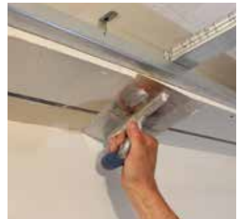
Oberflächen /Deckputz: Aufbringen von zb.einer Abspachtelung mit zb. Knauf Finissimo Universal in Qualitätsstufen Q3 oder Q4 möglich.
