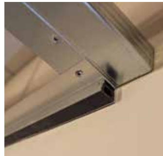
Montage einseitig an Wand, Befestigung mit Nieten an die Unterkonstruktion.
