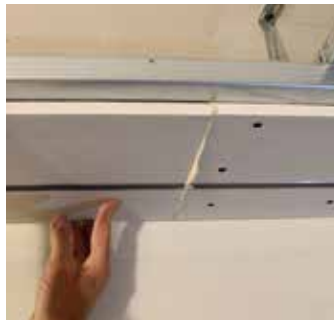
Weitere Grundprofilelemente an der Unterkonstruktion anordnen.
