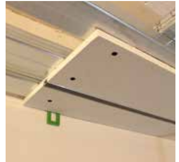
3 Schrauben je Elementbreite, siehe auch Schnitt D-D oder A-A.
