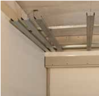
Erstellen der Unterkonstruktion nach Datenblätter und Systemskizze/Schnitte der Knauf AG.
