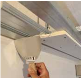
Vor der Montage von weiteren Grundprofilelementen im Stossbereich, Knauf Uniflott anbringen.
