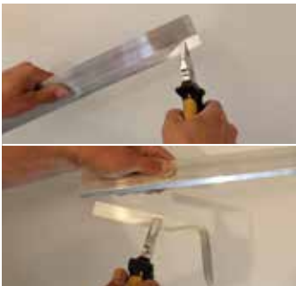
Aluminium Grundprofil bei Sollbruchstelle einseitig abtrennen.
