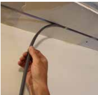
Nach Fertigstellung der Endoberfläche, Schutzabdeckung entfernen.
