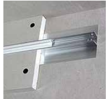
Beplankung der Deckenfläche mit z. B. 12.5 mm Knauf Bauplatten.
