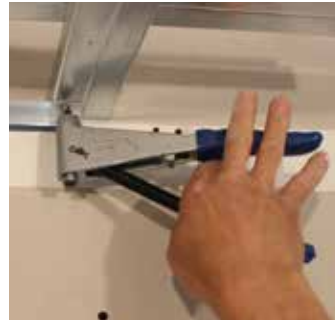
Befestigung an die Unterkonstruktion mit Nieten.
