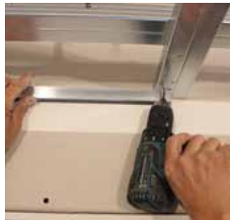
Montage einseitig, Befestigung mit Nieten an die Unterkonstruktion..
